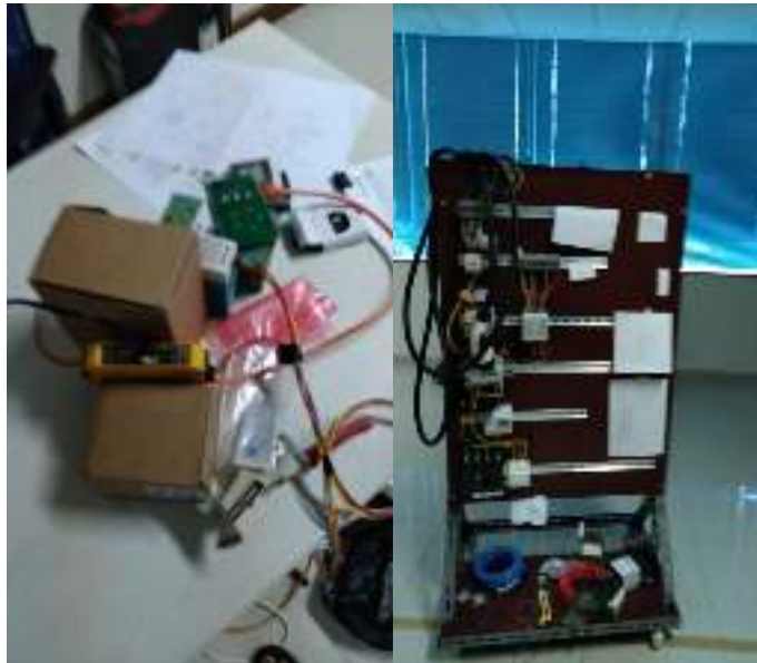
Gambar 01. Test Fungsi Komponen AC Charger
